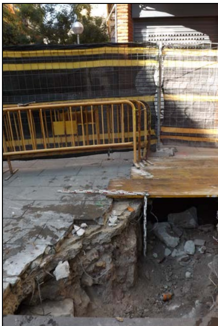
A l'esquerra el mur de façana UE 1004 i la seva posició i a la dreta la cantonada escapçada amb el mur UE 1005
