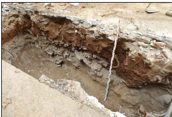
A l'esquerra vista del perfil de la Rasa en aquest tram i a la dreta l'arqueta de serveis UE 1016
