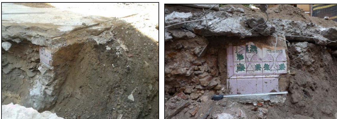
Vista general i en detall del mur UE 9005
