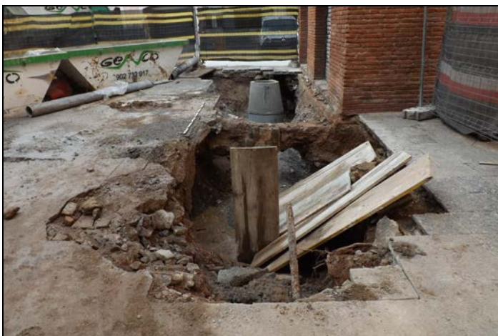
Vista dels serveis encofrats UE 1008
