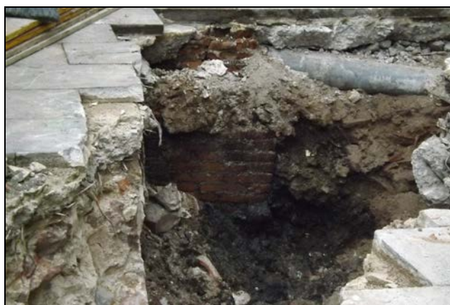
A l'esquerra vista de la trajectòria del Tram 2 de la Rasa 1 i a la dreta la fossa sèptica UE 1007
